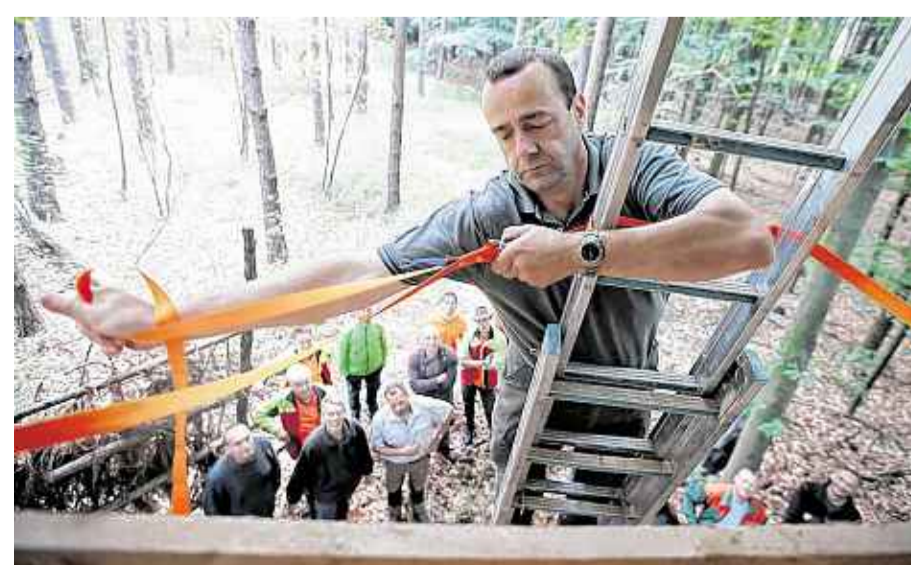
Forstwirtschaftsmeister Andreas Schwientek demonstriert das Sichern einer Leiter, um das Dach eines Anstanzes sicher zu reparieren. Foto: Jens Paul Taubert
