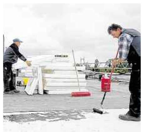
Mitarbeiter des Meisterbetriebes Lipfert bei Dacharbeiten auf der Klinik. Foto: Taubert
